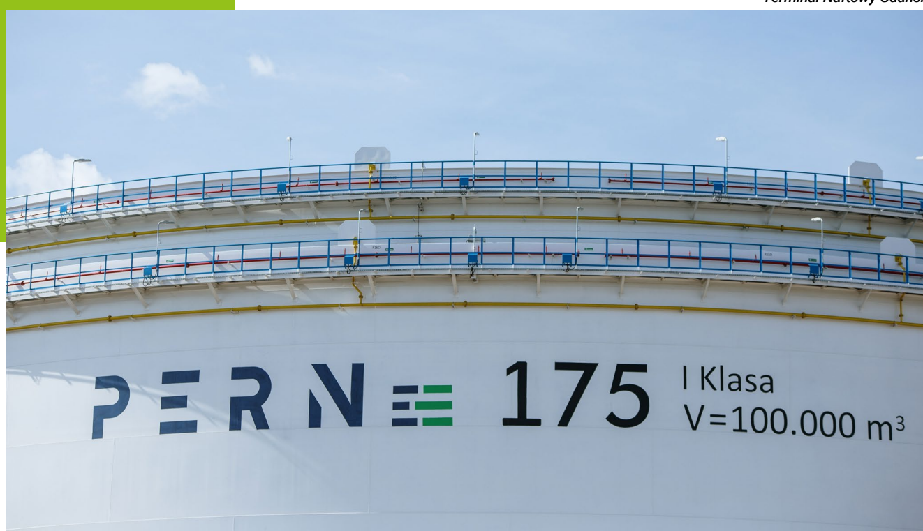
Terminal Naftowy Gdańsk
