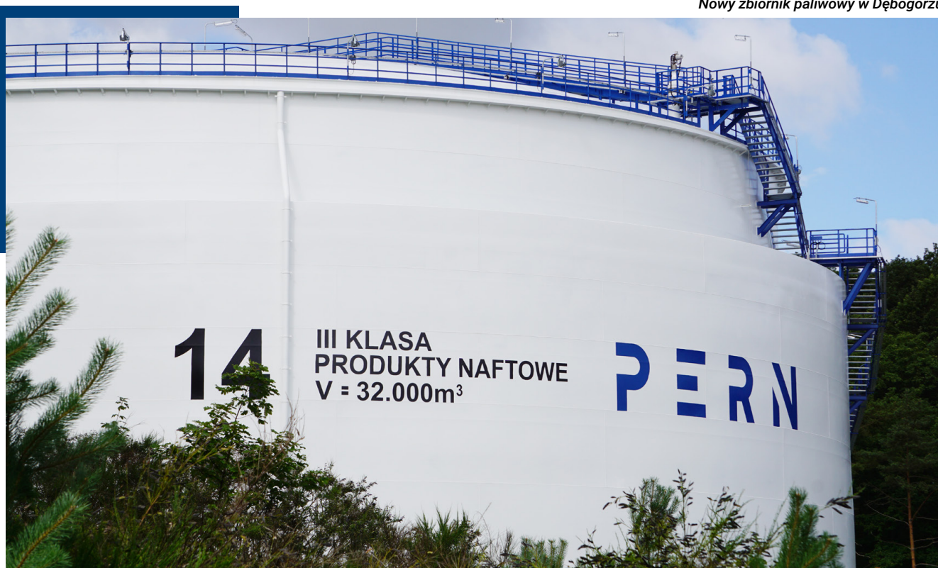
Nowy zbiornik paliwowy w Dębogórz
